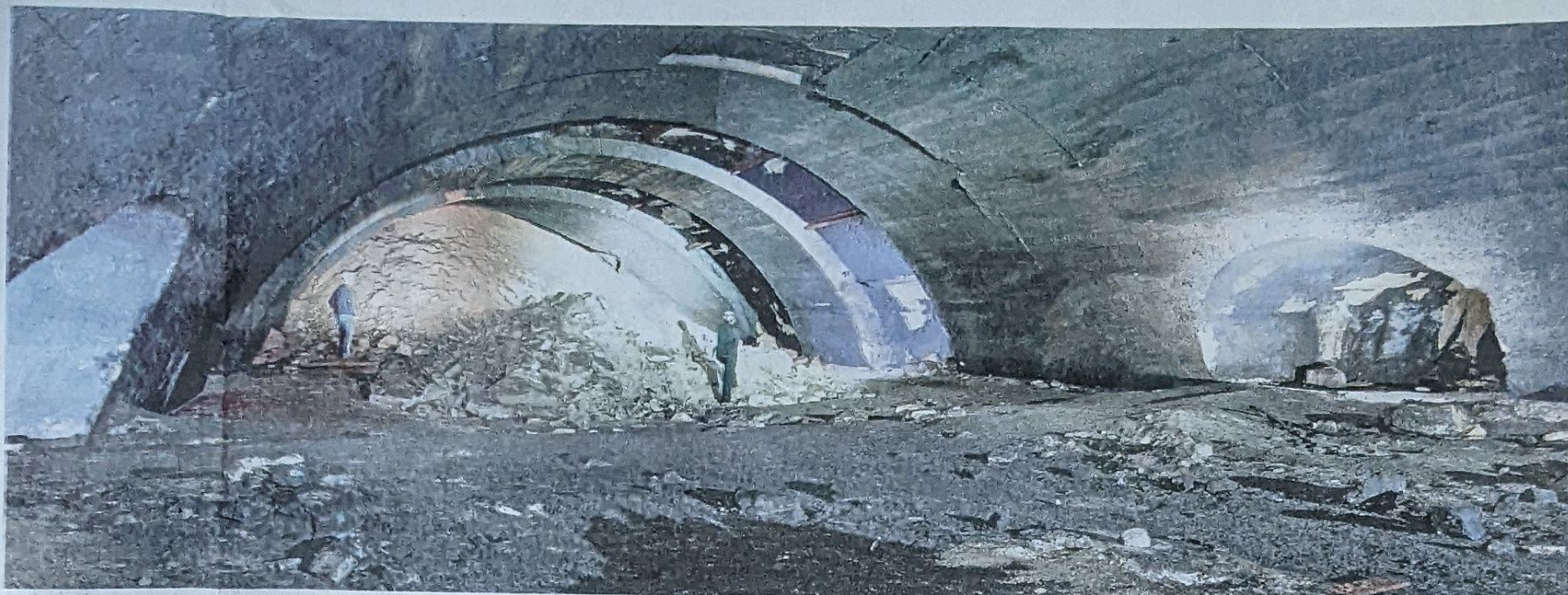
Im Walpersberg: Überreste einer 100 Meter langen und 15 Meter breiten Endmontagehalle. Ursprünglich sollte die Halle, als eine von insgesamt vier, 450 Meter lang werden.
